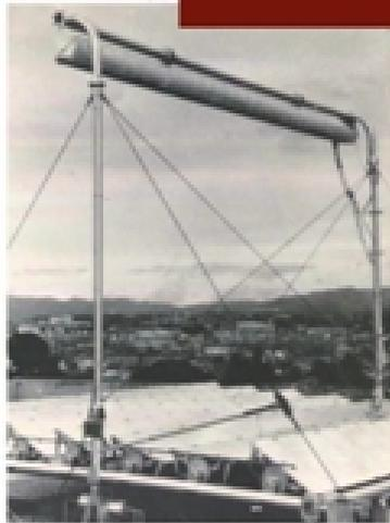
Tra il 1962 e il 1963 Francia progetta e assembla a Genova, costruisce e sperimenta a Marsiglia, con la collaborazione del francese Marcel Perrot, il primo sistema solare a concentrazione lineare Fresnel, capace di produrre vapore a 100 atm e 450°C.
